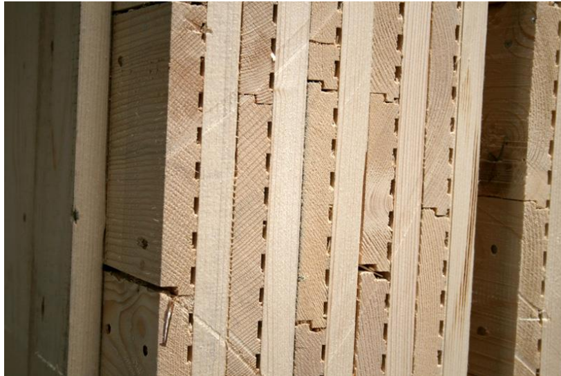
Figure 2.31 : Mur en lamellé croisé cloué MHM produit par Société Massiv-Hols-Maue
