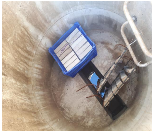
Figure 36 : Echantillons de pâtes de ciment et de mortiers placés sur le site S2p
