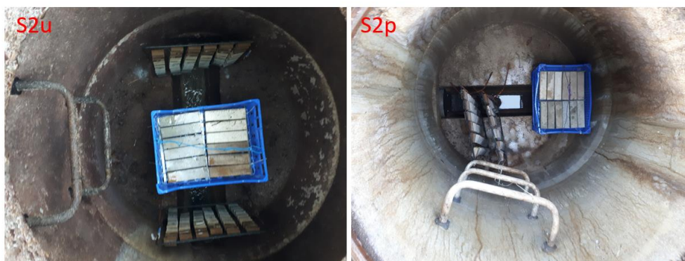
Figure 86 : Aspect des réseaux et des mortiers placés sur les 2 réseaux S2u et S2p du site S2
