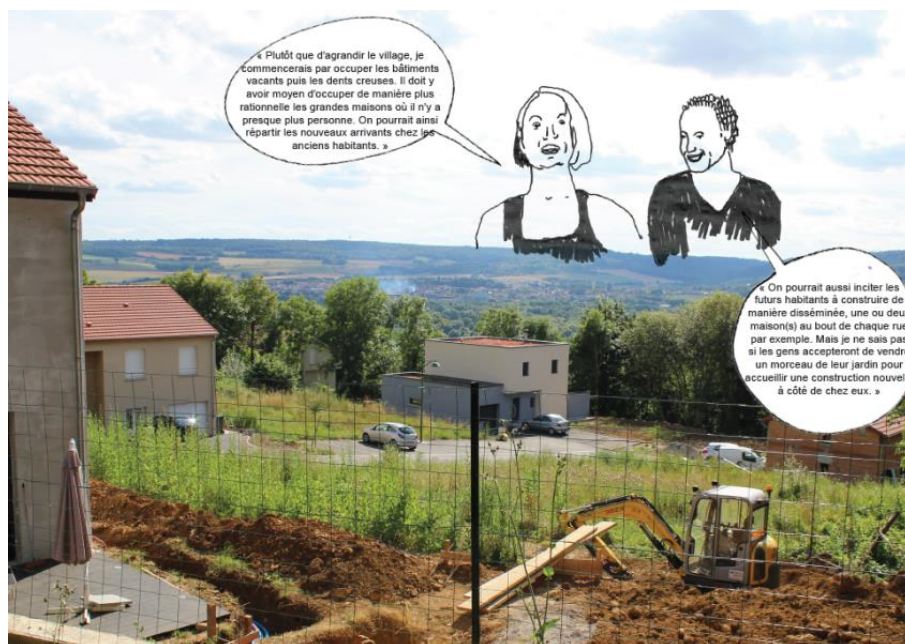
Figure 10. Photographie, « Le pavillon de la discorde » 220
