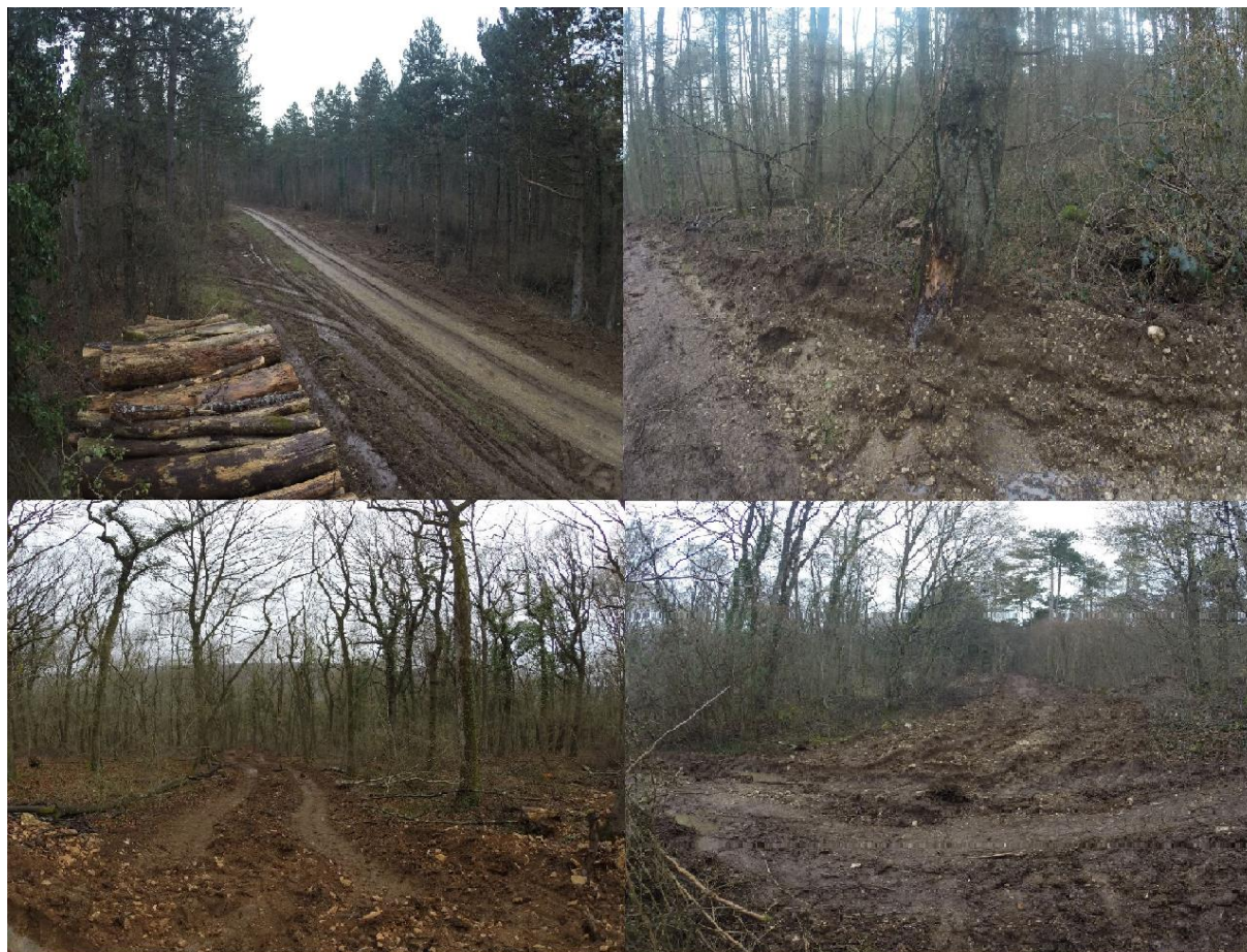
Figure 33. Photographies prises et échangées par les « habitants » inquiets des travaux forestiers à Ancy-Dornot (avril 2016)
