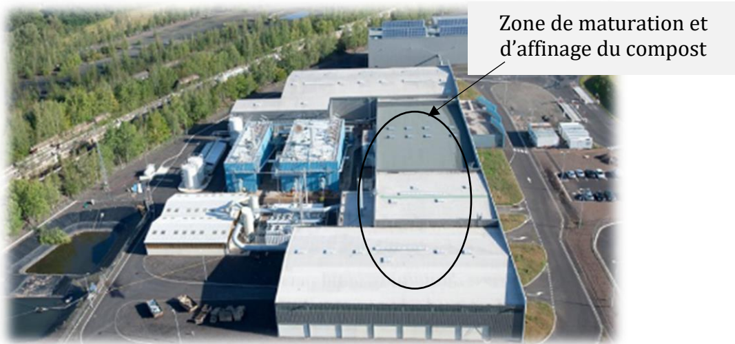
Figure 27 : Photographie de la zone de compostage de l'entreprise B.
