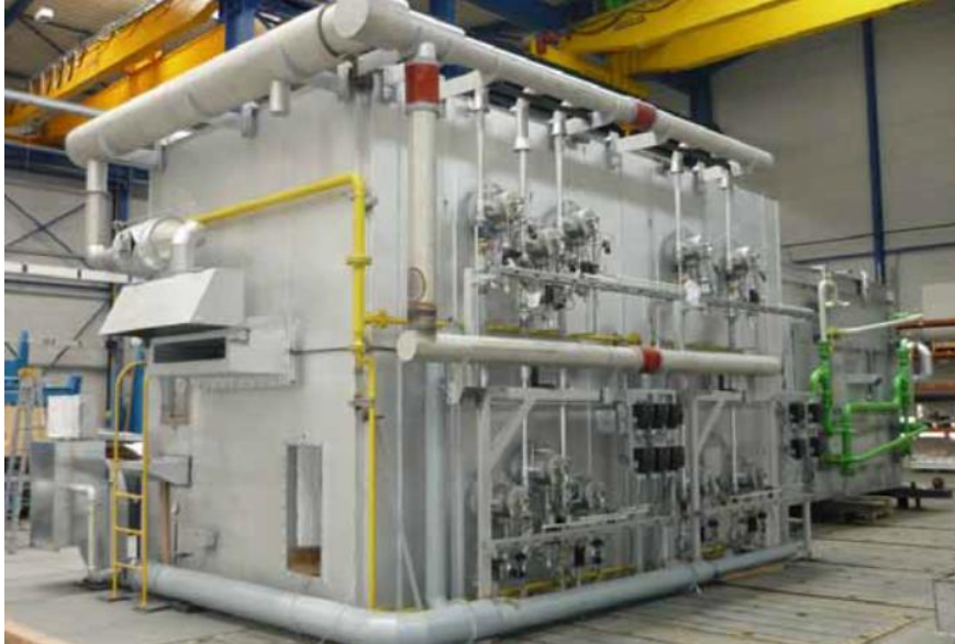
Fig.III.25 : Installation du four de cristallisation au cours de l'année 2015.
