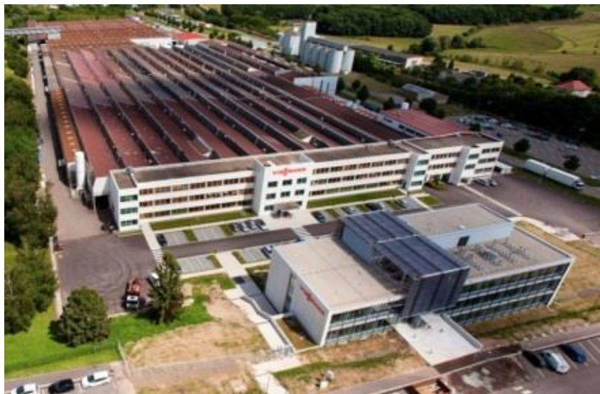
Fig III.1 : Vue aérienne de la société Viessmann Faulquemont SAS.
