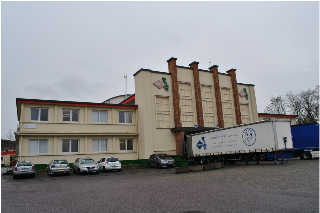
Figure 46 : site de l'ancien puits Simon 3, accueillant aujourd'hui l'entreprise Complet (rue Nationale, Forbach)
