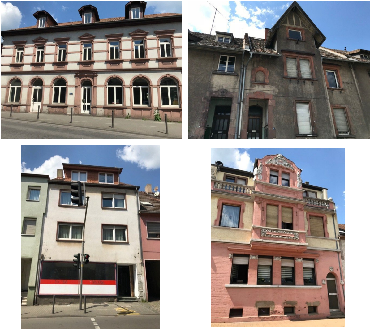
Figure 91 : quartier Unterer Wehrden marqué par les maisons d'ouvriers et celles des maîtres de forges (crédits photographiques : Frédérique Morel--Doridat, le 03/06/2018)
