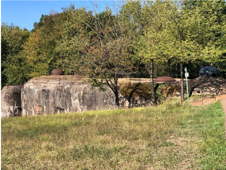
Figure 19 : le gros ouvrage du Hackenberg, bloc 9, ligne Maginot
