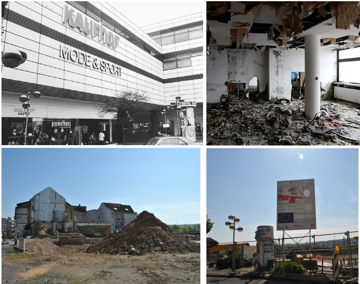
Figure 92 : démolition de l'ancien grand magasin Kaufhof laissé à l'abandon (en haut à droite) depuis sa fermeture à l'automne 1996
