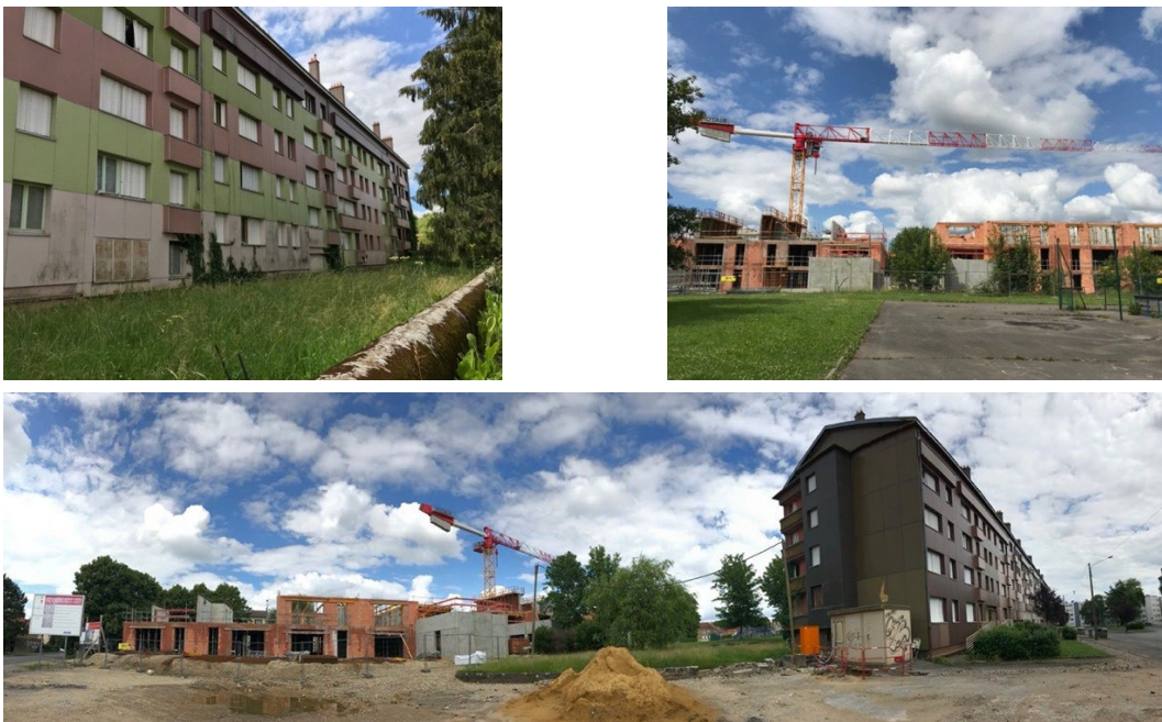
Figure 94 : NPNRU quartier Voltaire à Longwy : quand l'ancien dégradé (immeuble Voltaire) laisse place aux nouveaux logements
