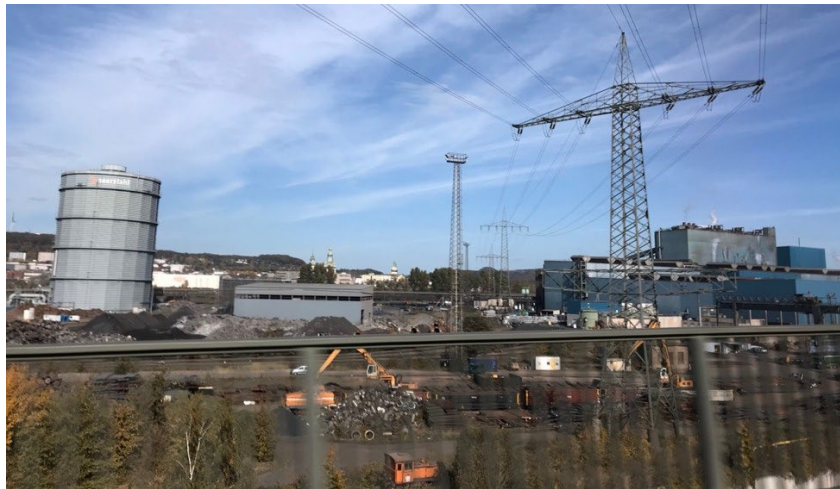
Figure 51 : nouvelle aciérie de Völklingen (vue depuis l'autoroute) (crédits photographiques : Frédérique Morel--Doridat, le 12 octobre 2018)
