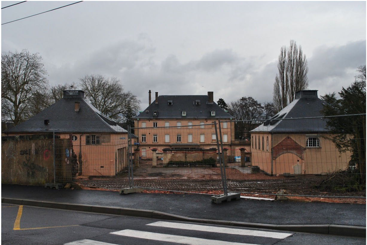
Ancien château Adt en cours de rénovation en vue de l'accueil du conservatoire de musique (en 2019) jusqu'alors situé dans l'un des anciens bâtiments de la caserne « Guise », rue Nationale (rue Forêt, Forbach)
