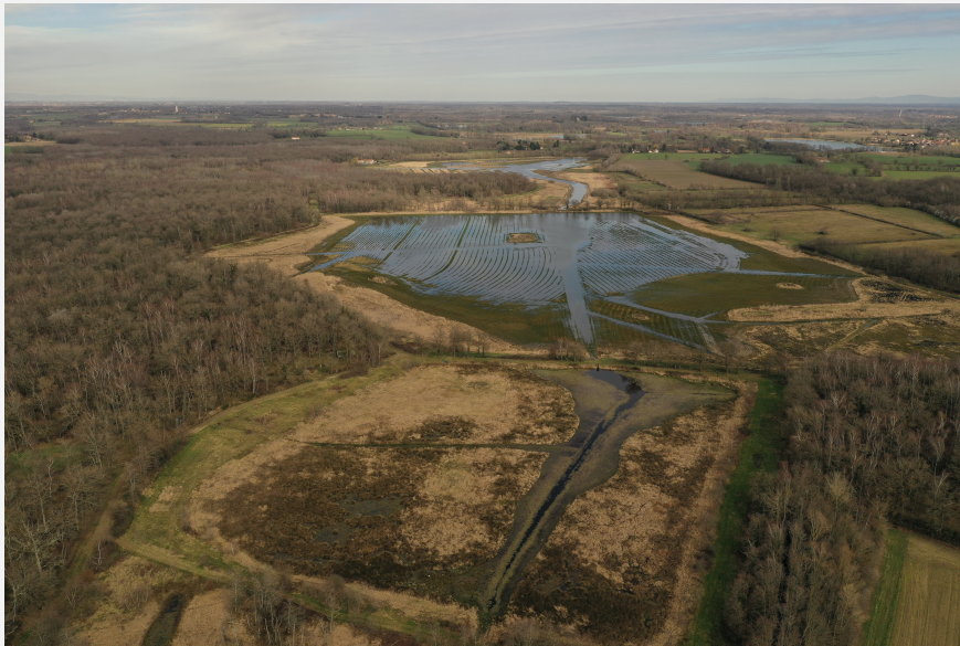
Aperçu aérien du domaine de la Fondation Pierre Vérots. Photo : P. Grandjean
