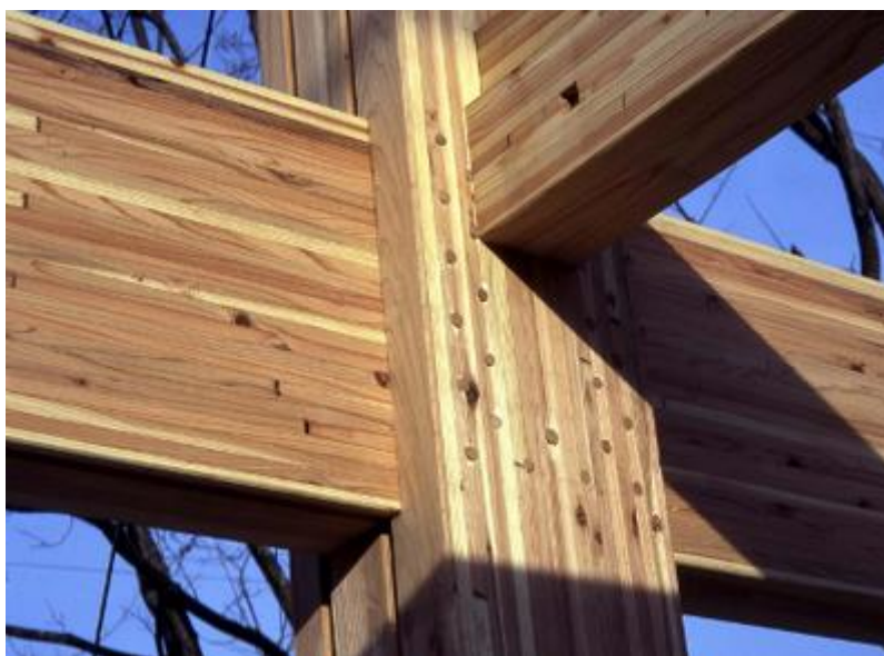
FIGURE 1 - Assemblage poteau-poutre réalisé par tourillons en densifié.
