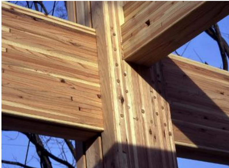
FIGURE 1 - Assemblage poteau-poutre réalisé par tourillons en densifié.
