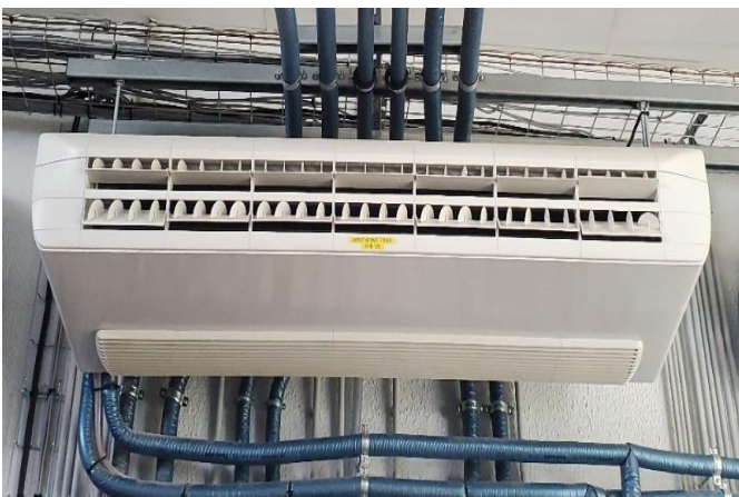
fig. 164 : Aérotherme Froid
