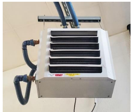
fig. 163 : Aérotherme Chaud
