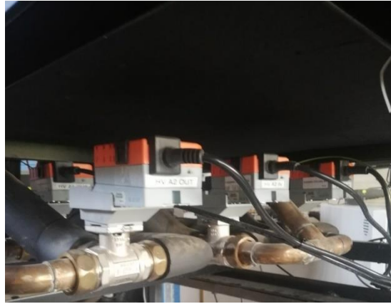
fig. 107 Vanne HV 3 voies du circuit hydraulique extérieur de la Machine à Adsorption SorTech
