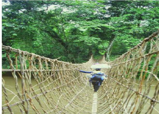
Figure 1-14: Pont en rotin du Cameroun [55]
