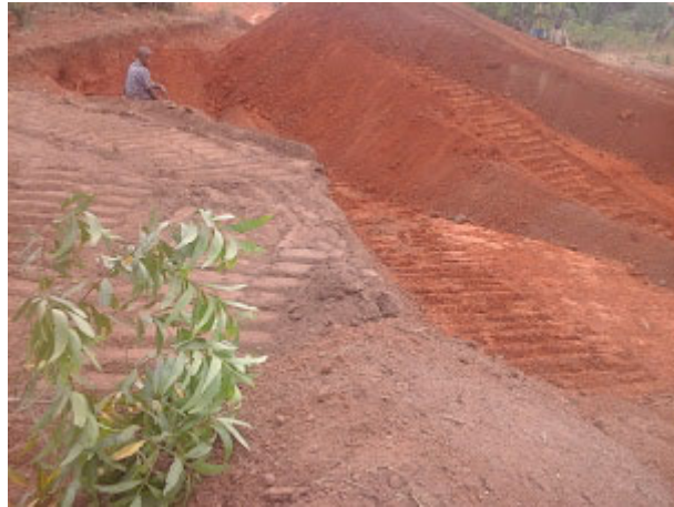
Photo 2-1 : Carrière de latérite de Attotinga, commune d'Allada
