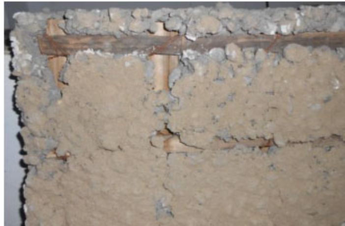
Figure 1-26: Mur armé de bambou [103]
