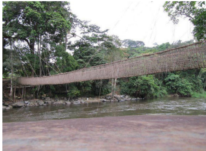
Figure 1-15: Pont en rotin au Gabon [57]
