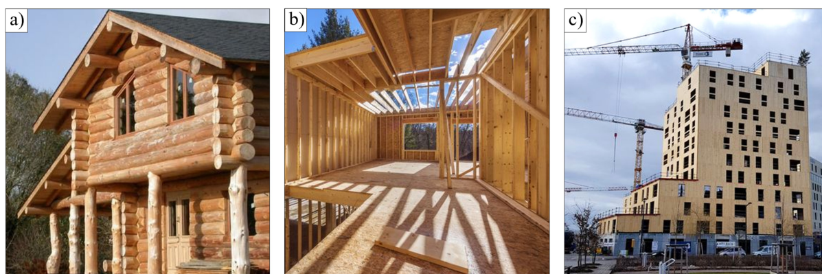
Figure 1.1- Exemple de typologie de construction bois utilisant principalement des essences résineuses a) Fuste ou bois empilé (magazine Marie Claire Maison), b) Ossature bois (Batimat) et c) Panneaux en bois lamellé-croisé collé (CLT : cross laminated timber) (Lignatec SAS)
