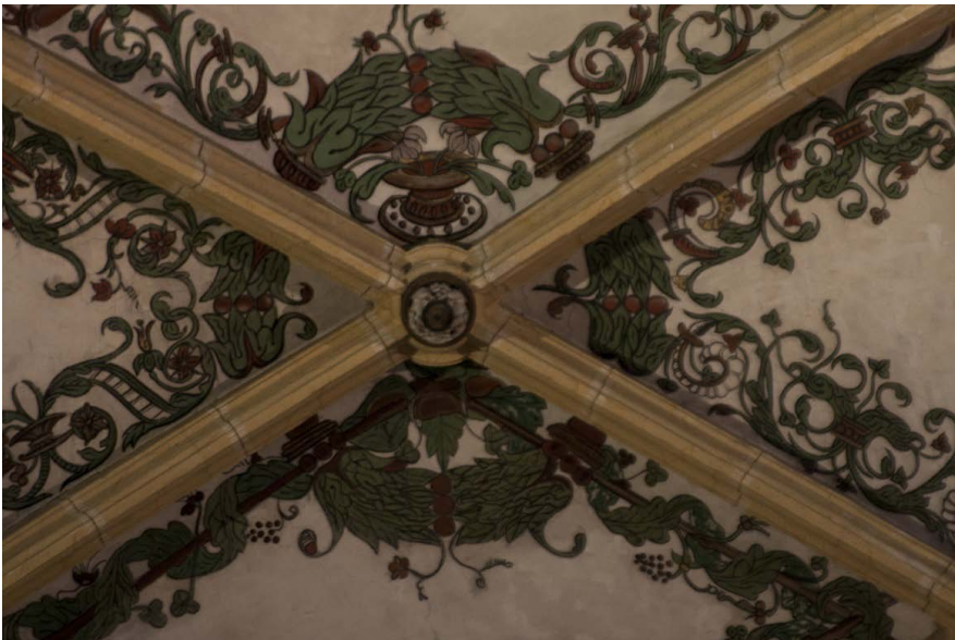
Cat. n° 8/11 - détail de la voûte du chœur (cliché de Matthieu Le Brech)
