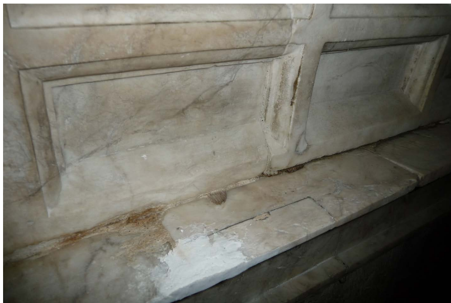
Cat. n° 32/41 - intrados de l'arc, bord inférieur gauche (cliché de Matthieu Le Brech)
