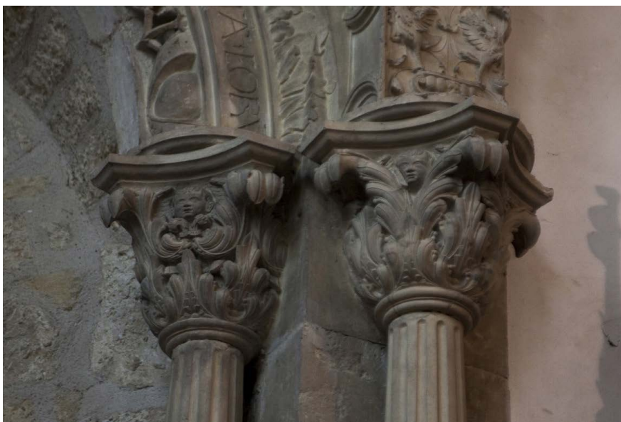
Cat. n° 8/23 - niche pour le siège des abbés, détail des chapiteaux des colonnes de droite (cliché de Matthieu Le Brech)
