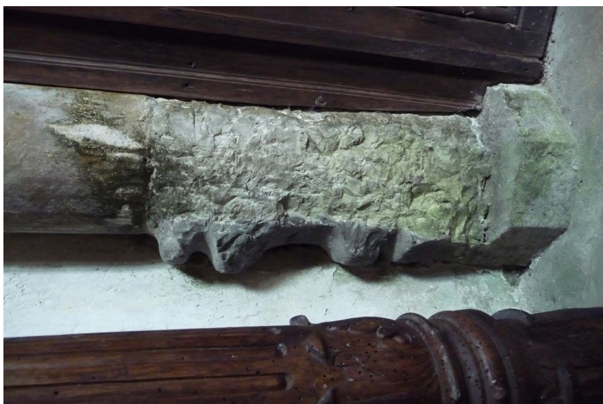
Cat. n° 8/9 - base prismatique d'une des retombées des voûtes du chœur (cliché de Nicolas Boffy)
