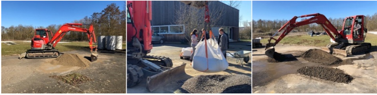
Figure 15. Préparation des mélanges pour le remplissage des lysimètres.
