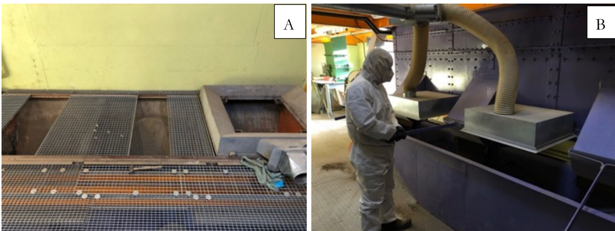
Figure 7. A : trémies d'alimentation ; B : alimentation du cribleur à partir des trémies.
