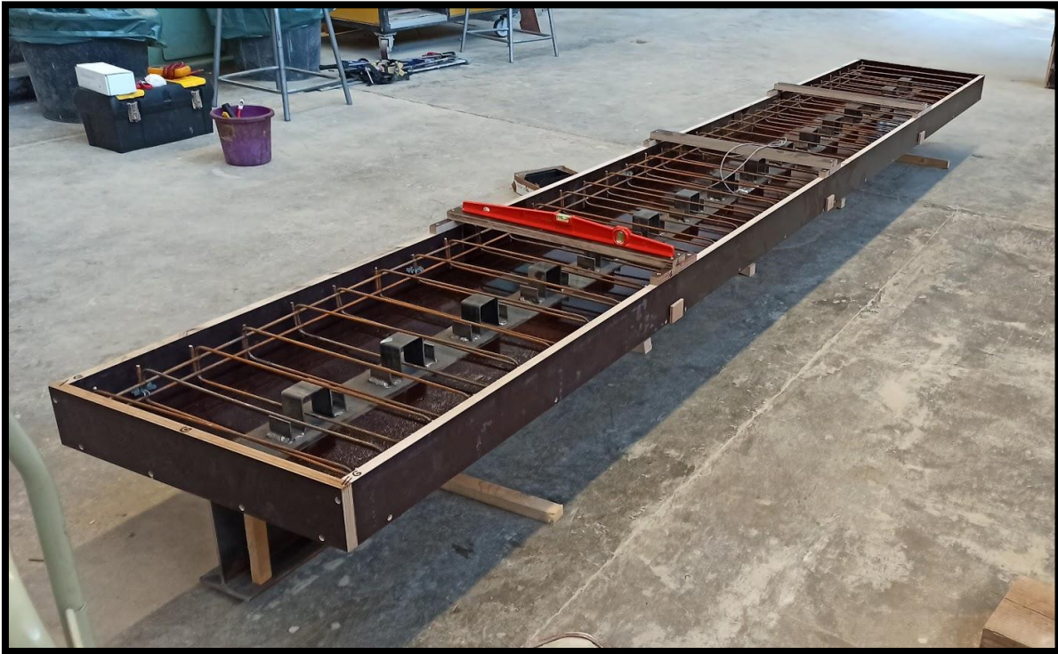
(d) Spécimen de poutre mixte prêt pour le coulage du béton.
