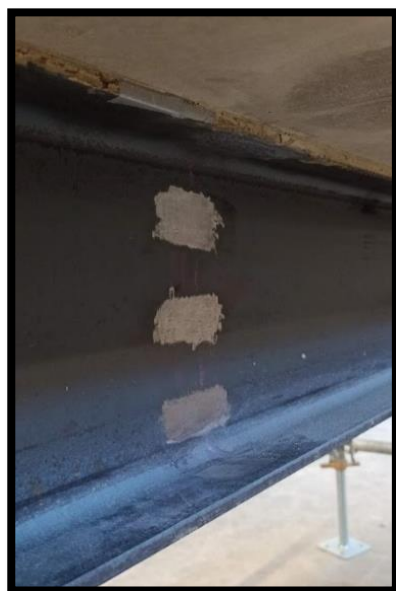
(a) Résine appliqué sur la surface du béton
