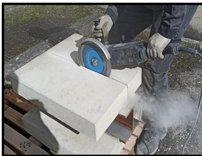
(b) Coupe longitudinale sur la dalle
