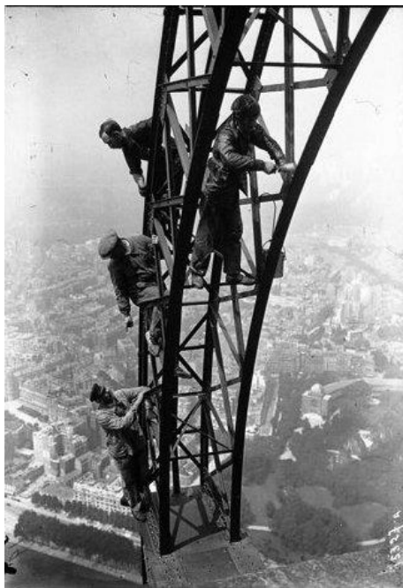
Figure 81 : Réfection de la peinture de la tour Eiffel, vers juin 1924 © agence Meurisse, © gallica.bnf.fr/BnF
