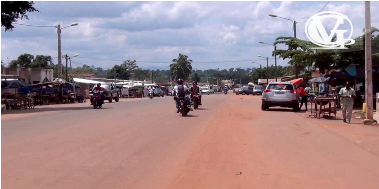
Figure 61 -Voirie de la Ville de Duékoué, photo reçue de la part d'un ami vivant à Duekoué
