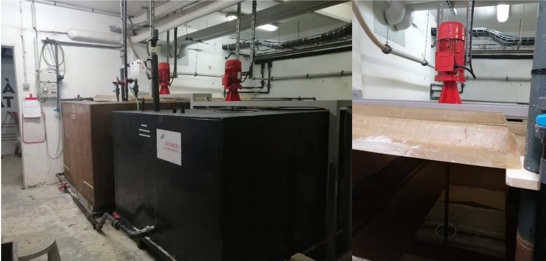
Figure II. 9. Cuve de préparation d'eau de mer
