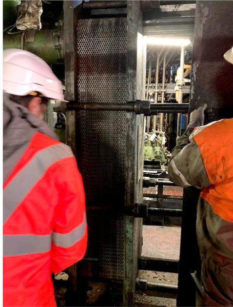
Figure VI. 37. Echangeur à plaques et joints sur un site lorrain
