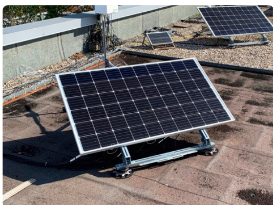
(c) Photographie du panneau photovoltaïque installé sur la parcelle végétalisée Bitume
