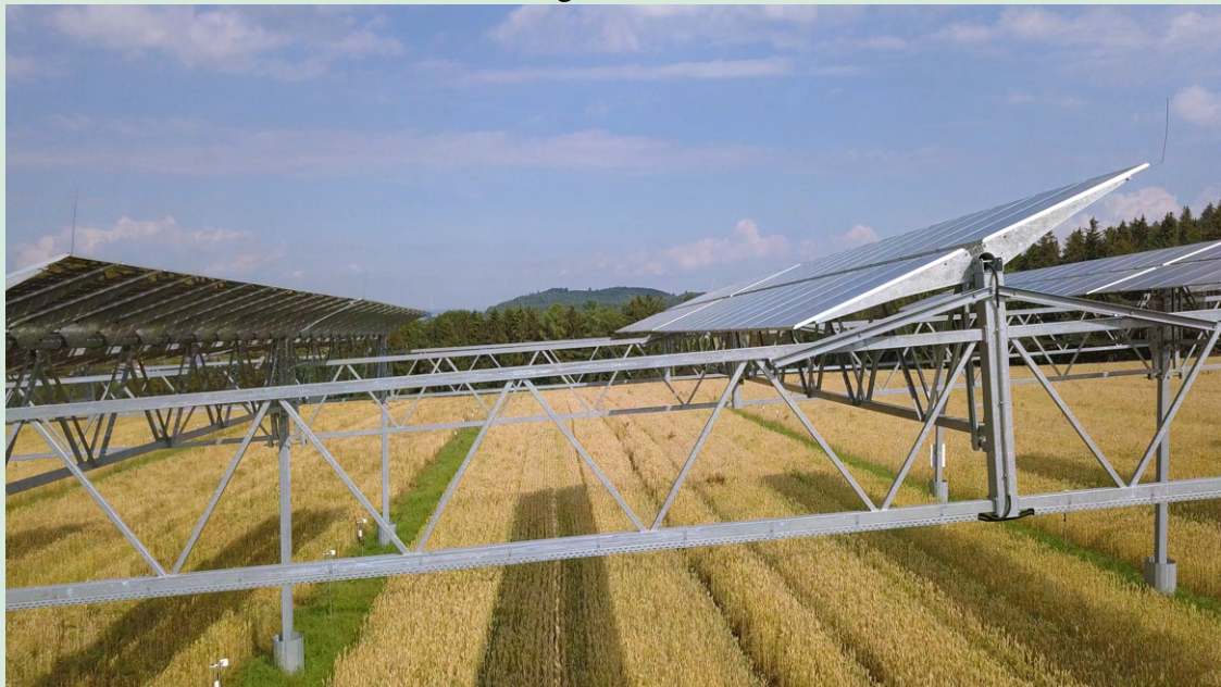
FIG. 1.18. : Illustration d'une installation agrivoltaïque en Allemagne.
