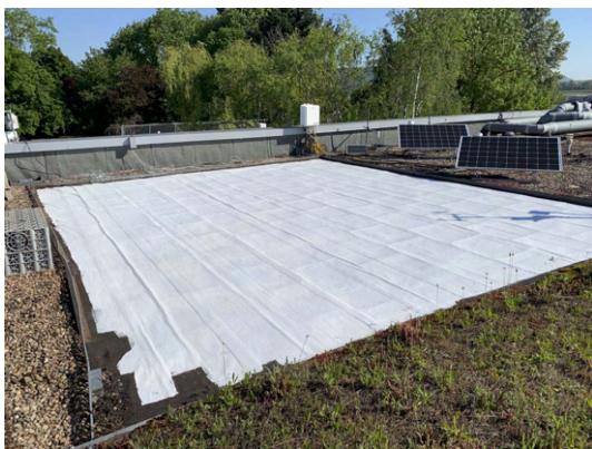
(a) Installation du revêtement Coolroof en mai 2022 au Cerema (Tomblaine).
