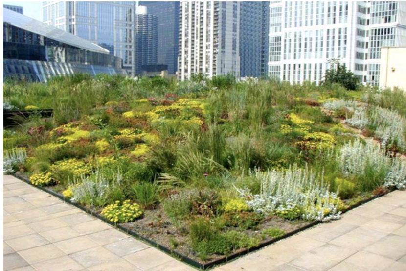
(b) Exemple de toiture intensive.
