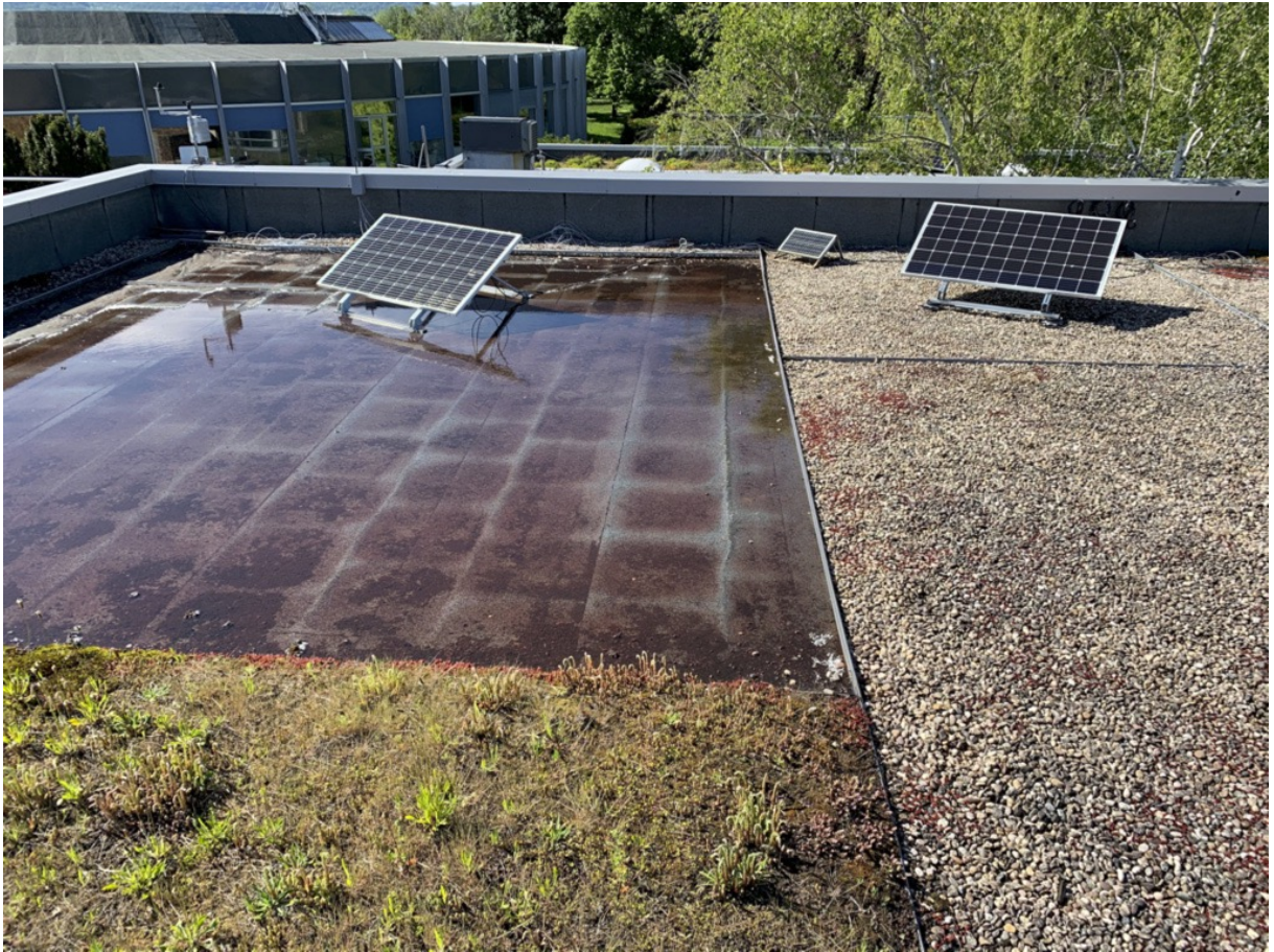
FIG. 2.6. : Photo de la parcelle Bitume disposée à côté de la parcelle Gravier avant l'installation de la parcelle Coolroof en mai 2022.
