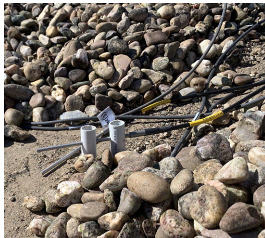
(b) Disposition des deux PT100 dans la verticale du gravier et sous le panneau.
