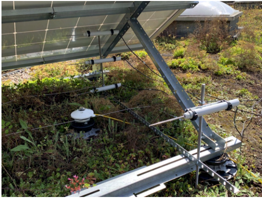
(a) Positionnement des sondes à boule chaude sous le panneau photovoltaïque Témoin .
