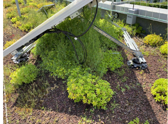
(b) Photographie de la végétation sous le panneau photovoltaïque Argile Expansée en saison estivale.
