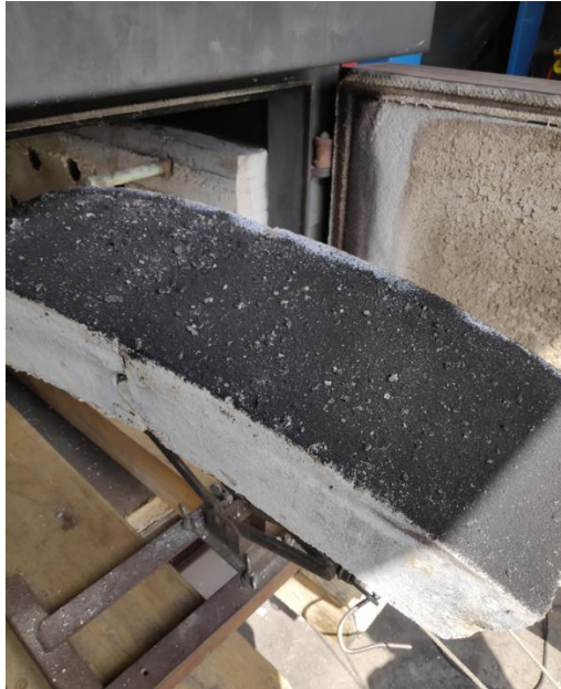
Figure 28 : La grille démontée avec les cendres déposées après un essai de combustion (zone 4)
