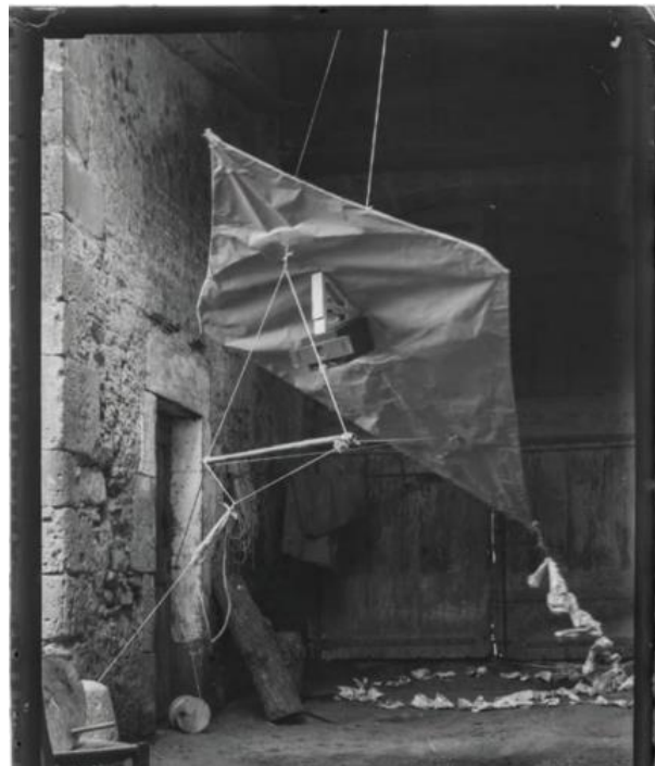
Figure 79 : Le cerf-volant utilisé par Arthur Batut pour capturer des photos aériennes (source : Espace photographie Arthur Batut).
