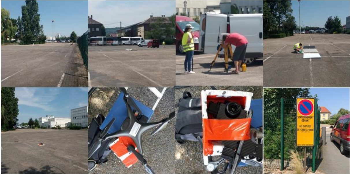
Figure 106 : Prises de vue au sol lors de la mission sur le parking de la route de Thionville avant travaux (crédits photo : Gilles Droque et l’auteur, légende des photos en Annexe 21 ).
