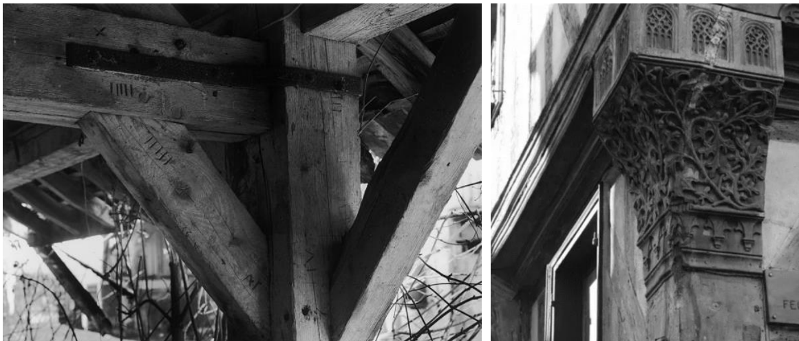
Figure 13. À gauche : Les marques de charpentier permettent d'identifier les pièces lors du montage, chaque pièce correspondant à une unique seconde (Roland, 2008); À droite : Une liberté formelle est associée au travail manuel, ici dans un travail d'ornementation du sommet des piliers corniers de maisons à pan de bois à Auxerre en France (Burguière-Labrunie, 2003).
