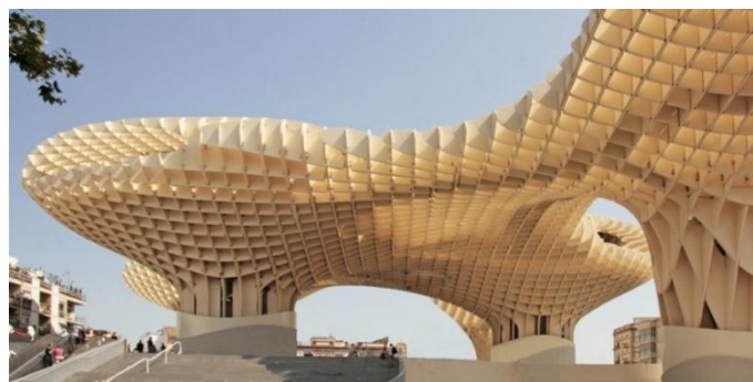
Figure 1. Stratification selon deux directions de la géométrie complexe du projet Metropol Parasol de Séville. D'après (Bignon, 2021).
