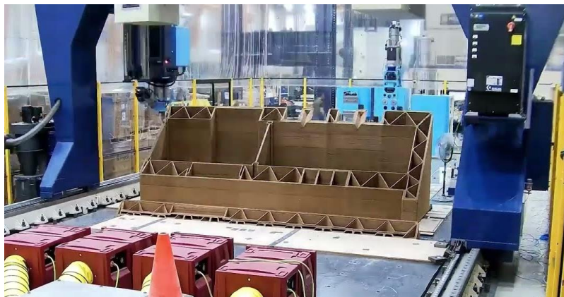
Figure 7. Fabrication par le procédé FFF du projet BioHome3d. La fabrication repose sur l'utilisation d'une solution d'imprimante sur portique d'une capacité dimensionnelle de 30 m x 6 m x 3 m. Disponible à l'adresse : https://urlz.fr/nAgw [Consultée le 13 septembre 2023]
