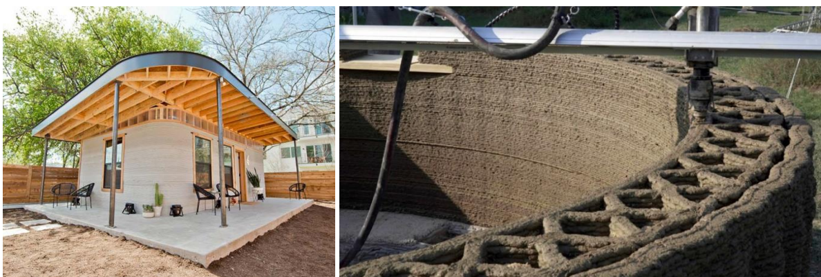
Figure 9. Complexité géométrique des projets réalisés par des procédés d'extrusion de matériaux : le projet The Chicon House réalisé par ICON aux Etats-Unis présente des parois courbes (à gauche) ; le projet GAIA réalisé par WASP en Italie présente des parois dont la structure est alvéolaire (à droite). Disponibles à l'adresse : https://urlz.fr/nFqc et à l'adresse : https://urlz.fr/nFqf [Consultées le 13 septembre 2023]
