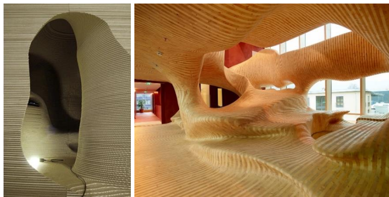
Figure 5. Fine discrétisation du modèle numérique dans sa matérialité physique apportant une continuité visuelle du profil des strates : par utilisation de strates de faible épaisseur dans le projet Mafoombey (à gauche) et par utilisation d'un usinage 5 axes dans le projet Body (à droite). Disponibles à l'adresse : https://urlz.fr/nAgj et à l'adresse : https://urlz.fr/nAgs [Consultées le 13 septembre 2023]
