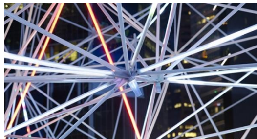
Figure 11. Projet ( ultra ) Light Network comprenant des nœuds d'assemblage intégrant un support d'éclairage. Disponible à l'adresse : https://urlz.fr/nFqu [Consultée le 13 septembre 2023]
