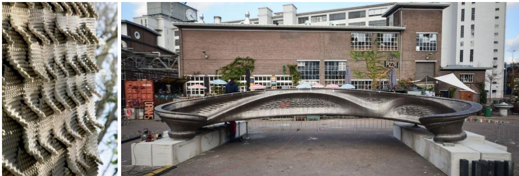
Figure 10. Liberté formelle expérimentée à différentes échelles : système de revêtement de façade Seed Stitch mis en œuvre dans le projet Cabin of 3D Printed Curiosities par Emerging Objects (à gauche) et MX3D Smart Bridge (à droite). Disponibles à l'adresse : https://urlz.fr/nFqi et à l'adresse : https://urlz.fr/nFqq [Consultées le 13 septembre 2023]
