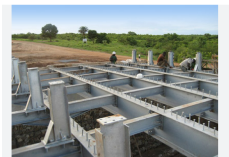
Figure 1.7 – Construction de ponts routiers à poutres.
