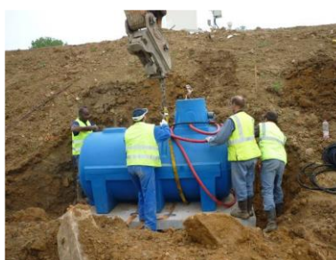
Pose de la cuve sur socle béton
