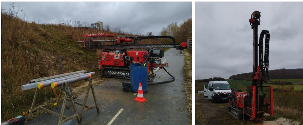
Figure II.28. Carottages horizontaux et verticaux effectués en 11/2023.
