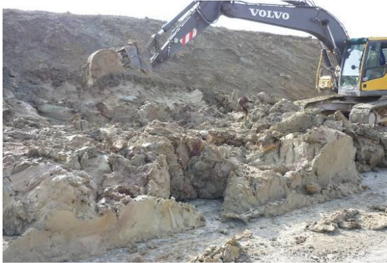
Mise en couche de l'argile avant traitement
