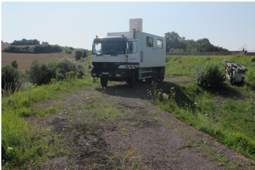
Figure II.23. Sondages CPT-U pendant l'intervention sur le remblai d'Héricourt du 08/2021.
