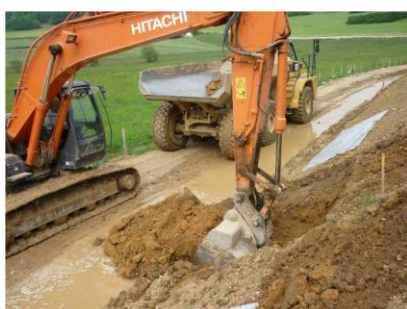
Excavation en pied de remblai pour installation de la cuve
