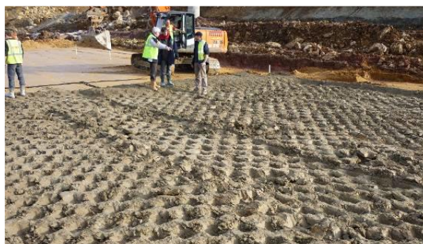
Couche de remblai après compactage au VP5
