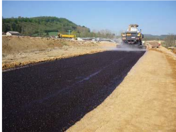
Figure II.10. Seconde couche d'émulsion sur l'assise du remblai (Froumentin, 2012).
