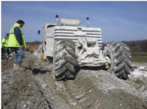
Malaxage de l'argile traitée à la chaux
