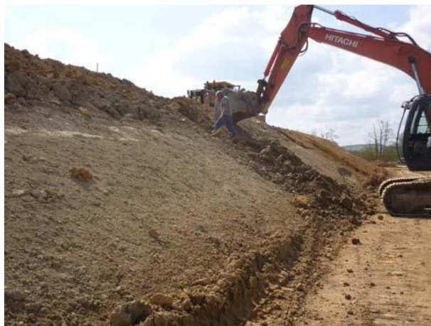
Figure II.11. Retaillage des talus selon la méthode excédentaire (Froumentin, 2012).
