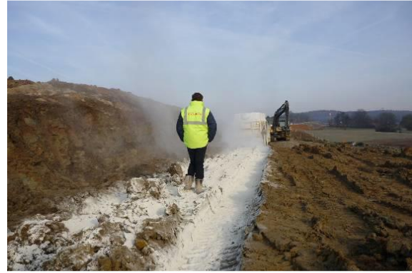
Épandage de la chaux sur l'argile
