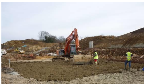
Mise en œuvre du matériau traité
