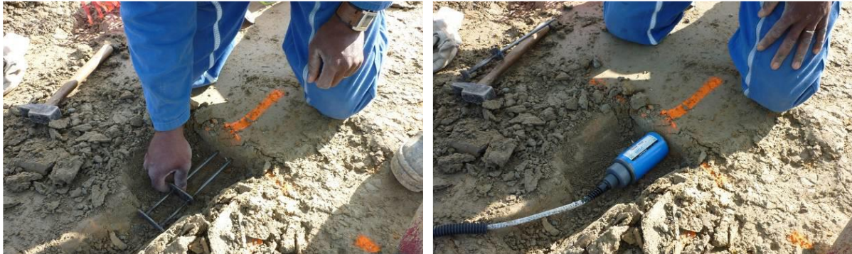
Mise en place du gabarit et perçage des trous
